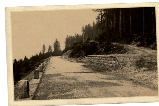
Teil des neu erbauten Straßenabschnittes bei der Unterstmatt. Typisch waren die Holzpolder-Vorrichtungen mit dem Zugang zu den Holzabfuhrwegen.
